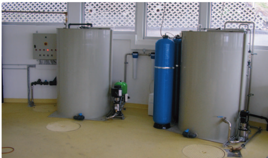
Les osmoseurs compacts proposés par l'entreprise DLK Technologies se distinguent par leur simplicité. Ils sont conçus pour fonctionner automatiquement, avec un minimum de support technique.
